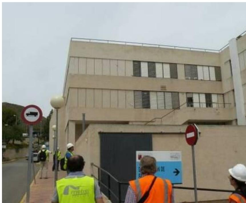
**Tipología:** El hospital se encuentra en una estructura modular compuesta. Su estructura es de pilares y forjados de hormigón armado. La ampliación es una estructura de pórticos de acero con muros de relleno de mampostería no reforzada.
