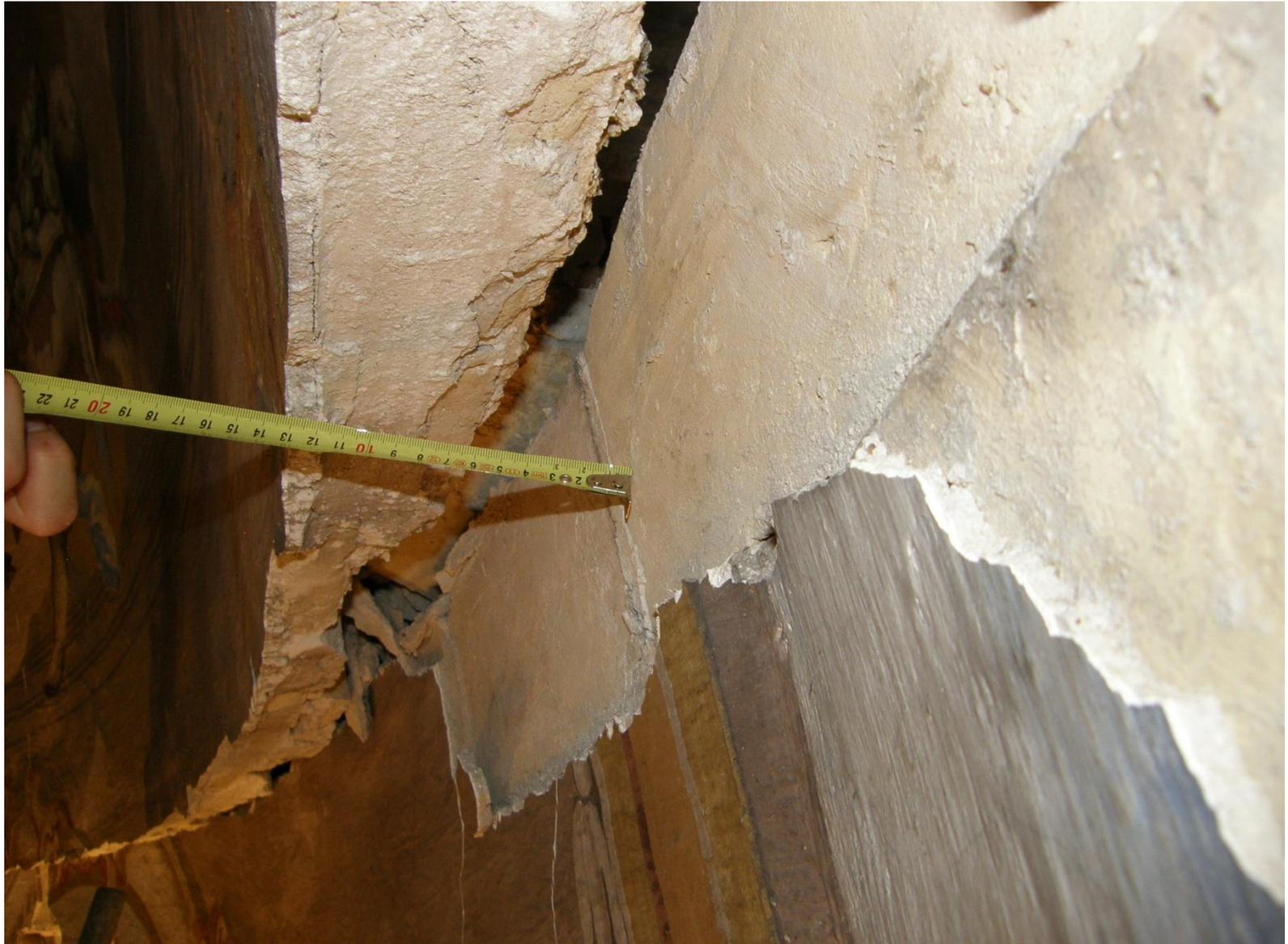
Agrietamiento importante en arcos y contrafuertes.
