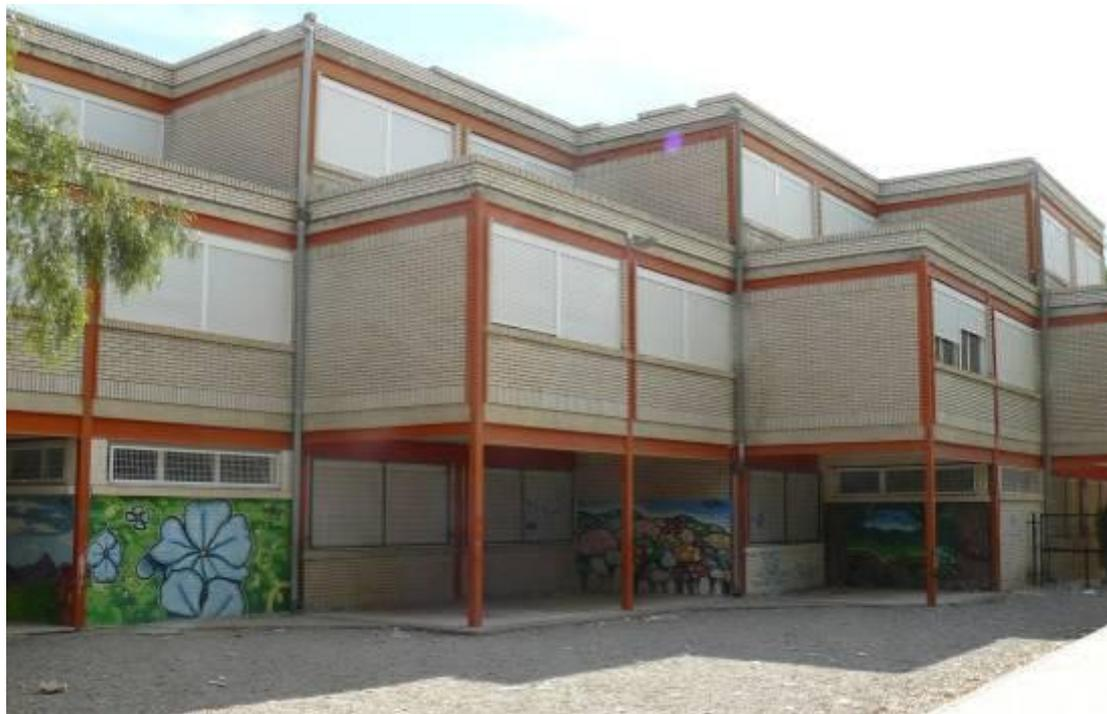
**Tipología:** Edificio de pórticos metálicos con muros de relleno de mampostería no reforzada.
