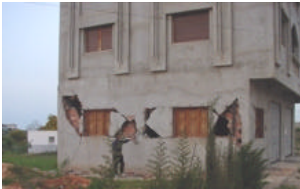
Fotos 14 i 15. Edifici amb pilar xafat. Detall dels danys. La intensitat sembla ser superior al grau VIII.
