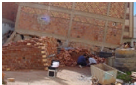
Fotos 8 i 9. Dues vistes d'un edifici col·lapsat on es va efectuar una mesura de soroll sísmic (grau de dany 4-5).
