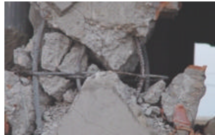
Fotos 14 i 15. Edifici amb pilar xafat. Detall dels danys. La intensitat sembla ser superior al grau VIII.
