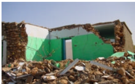
Fotos 19 i 20. Exemple de danys de grau 5 en construccions de tipus A.
