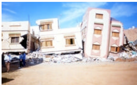
Fotos 10 i 11. Dues vistes d'un edifici col·lapsat on es va efectuar una mesura de soroll sísmic (grau de dany 4-5).
