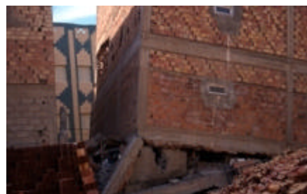
Fotos 8 i 9. Dues vistes d'un edifici col·lapsat on es va efectuar una mesura de soroll sísmic (grau de dany 4-5).
