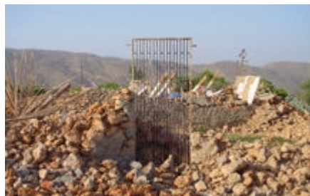
Fotos 19 i 20. Exemple de danys de grau 5 en construccions de tipus A.
