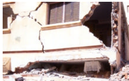
Fotos 10 i 11. Dues vistes d'un edifici col·lapsat on es va efectuar una mesura de soroll sísmic (grau de dany 4-5).
