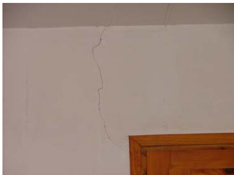
Figura 8. Danys ocasionats pel terratrèmol del 21 de setembre de 2004 a l'edifici de l'Ajuntament de Queralbs.
