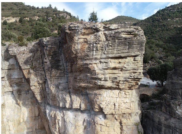
Treballs per mitigar el risc de despreniments a Sant Miquel del Fai: malles i ancoratges per estabilitzar la roca a la zona de la Foradada.
