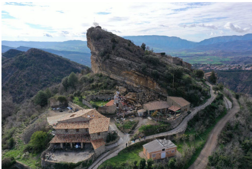
Assistència a la valoració i obres de correcció del despreniment a Santa Engràcia (Trempe).
