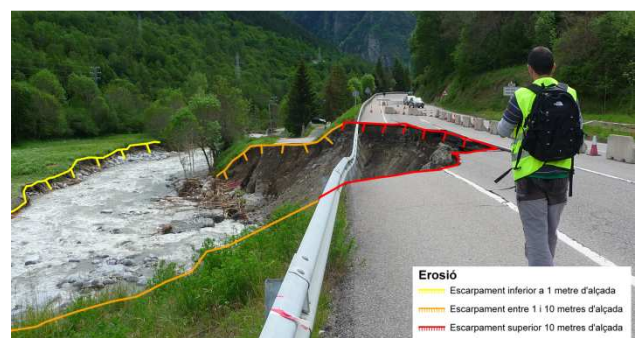
Figura 4 – Fotografia de la soscavació a la carretera C-28, PK 32+200, Gessa (Naut Aran) on s'exemplifiquen els escarpament cartografiats (IGC, 20/06/2013).
