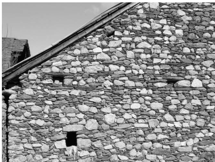
FIGURA 25. La proporció de caireslls de gresos i pissarres del Cambroordovicià (roques fosques) i de granitoides (roques clares) és similar a la major part dels edificis de Son. Les lloses gruixudes de gresos i pissarres s'aprofiten per fer fileres regulars. Els caireslls de granitoides són relativament irregulars. Per a les petites llindes s'utilitzen indistintament lloses o carreus de granitoides. En segon terme, es veu el llosat d'una casa, colonitzat per líquens.
