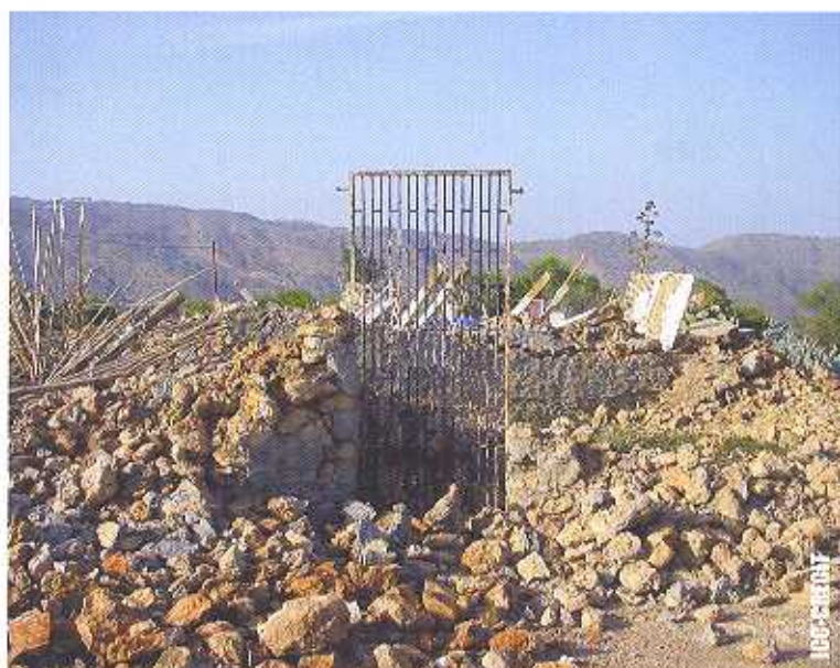
Zones rurals d'Ait Kamra i d'Ifassayen. Exemple de danys de grau 5 en construccions de tipus A.
